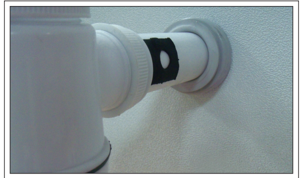
(Resim 6) 40mm plastik sifon boruya sızdırmazlık contası yapıştırılır
