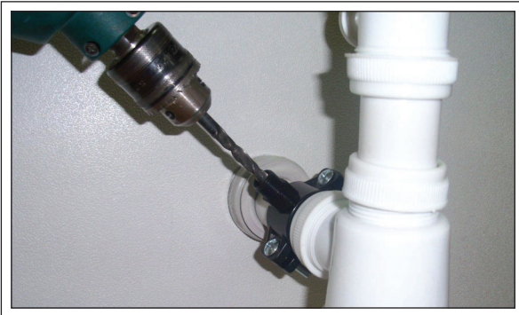
(Resim 7) 3/8" atık su kelepçesi takılarak 9'luk matkap ucu ile delik açılır
