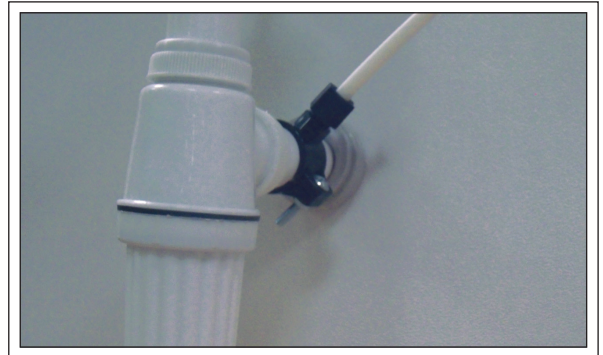
(Resim 8) 3/8" Atık su hortumu atık su kelepçesine takılır.
