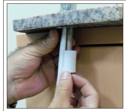
Resim 12: Plastik musluk montaj parçası
