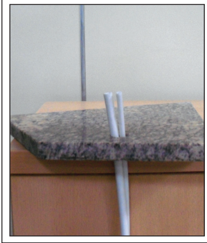
Resim 6: 3/8" ve 1/4" atık su hortumları açılan delikten geçirilir.
