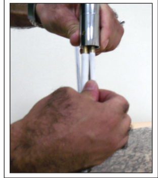
Resim 9: 1/4" atık su hortumu montajı
