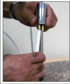
Resim 8: 3/8" atık su hortumu montajı
